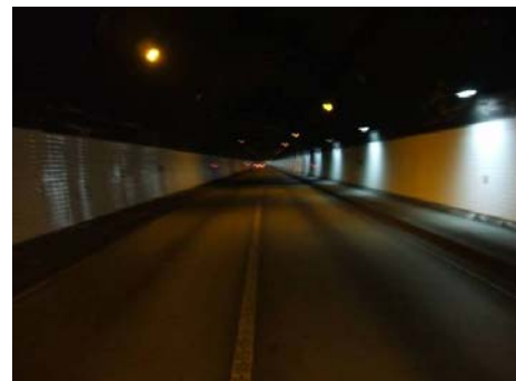
写真-2 清掃後のトンネル内
