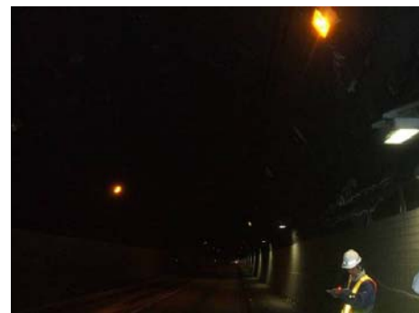
写真-1 清掃前のトンネル内
