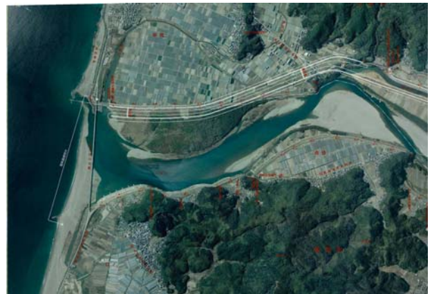
図-1 仁淀川右岸河口高水敷状況写真
