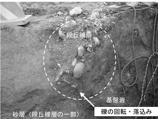
写真-2 断層面付近の変形構造(水路工掘削溝内)
