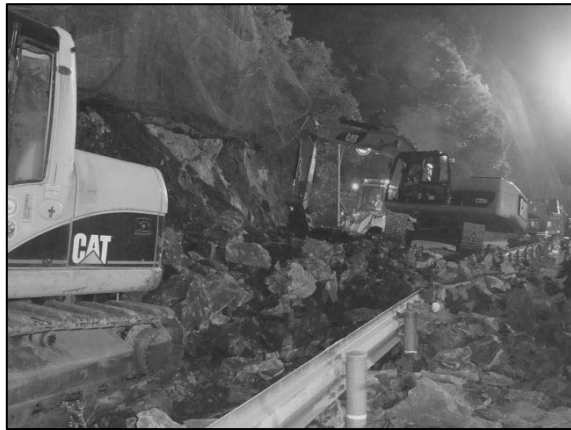
写真-8 土砂撤去状況写真
