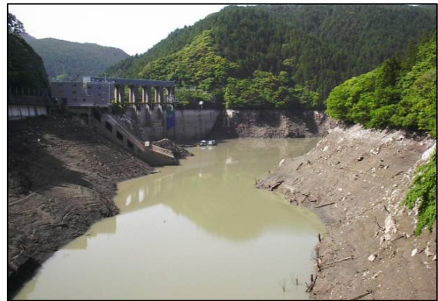
長安口ダム 濁水時：貯水率1.7%
