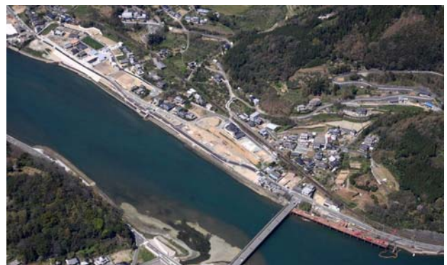
上老松地区俯瞰（上：事業前、下：平成22年4月）
