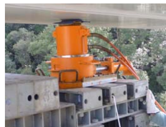
写真-1 スライド式送り台
