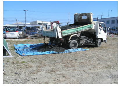
写真 - 5 底土の運搬状況
