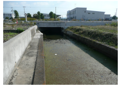
写真 - 8 工事完成後の写真
