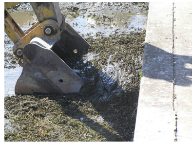
写真 - 4 底土の鋤取り状況
