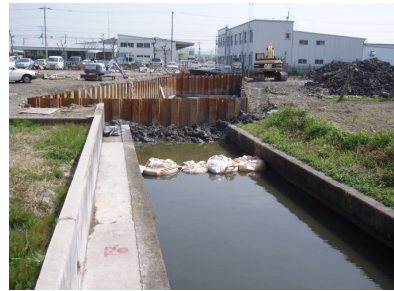
写真 - 7 仮締切工、BOX 施工状況
