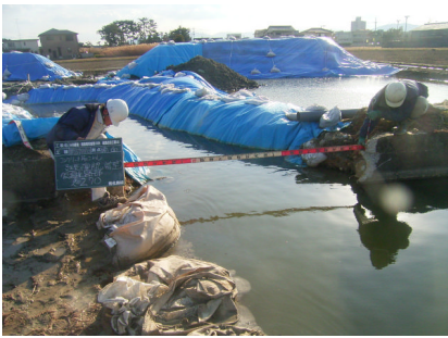
写真 - 12 大型の仮水路
