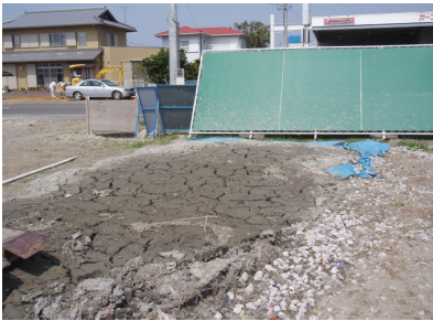
写真 - 6 底土をヤード内で保管
