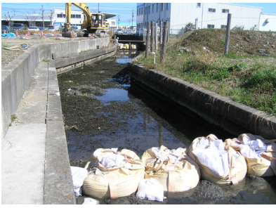
写真 - 3 既存地の土嚢による止水状況
