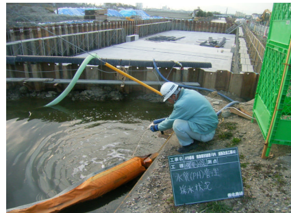
写真 - 13 現場からの排水の水質調整
