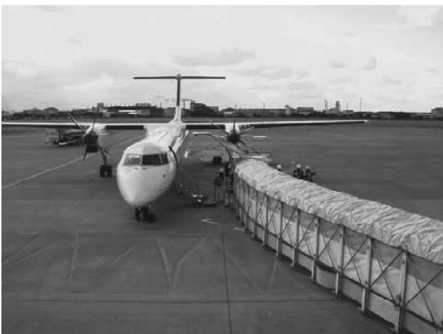
図-1 松山空港におけるエプロンルーフ
