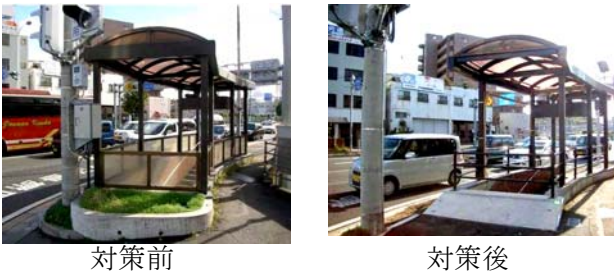
写真2 地下歩道の状況
