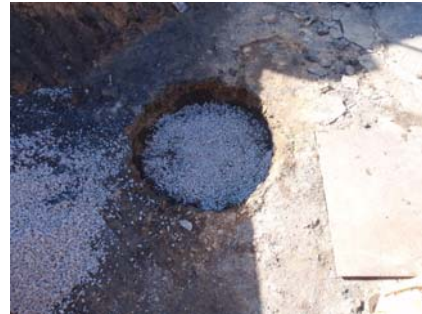
写真-7 ウェルドレーン完成 (STEP5)
