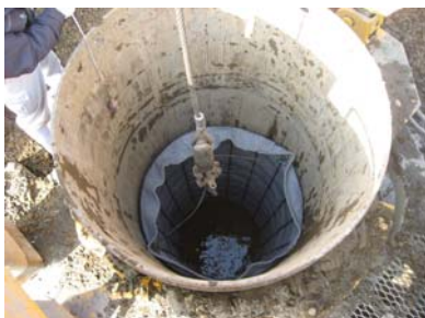
写真-4 鉄筋カゴの据付 (STEP2)
