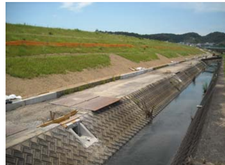
写真-8 排水路完成 (STEP6)
