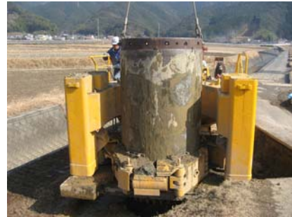
写真-6 ケーシングの引き抜き (STEP4)
