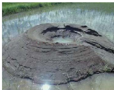
写真-1 パイピング現象による噴砂（平成17年9月台風14号）
