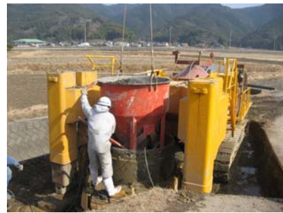
写真-5 ドレーン材の充填 (STEP3)
