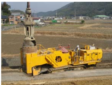
写真-3 オールケーシング掘削機にて削孔 (STEP1)
