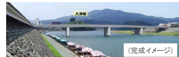
【一般国道56号 肱川橋橋梁架替(愛媛県大洲市)】
