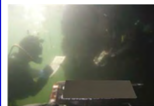
小型船を使った目視点検 (栈橋下部)
