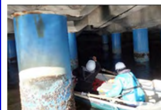
小型船を使った目視点検 (栈橋下部)
