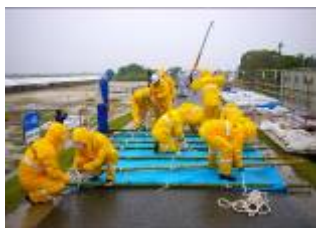
シート張り工
