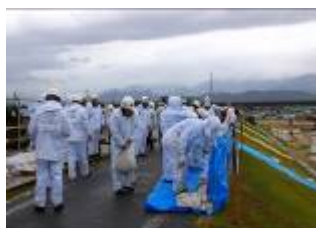
改良積み土のう工
