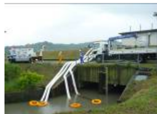
内水排除訓練
