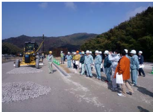
グレーダの敷均し状況
