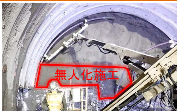
現場での使用状況 （危険な切羽の直下での人による作業なし）
