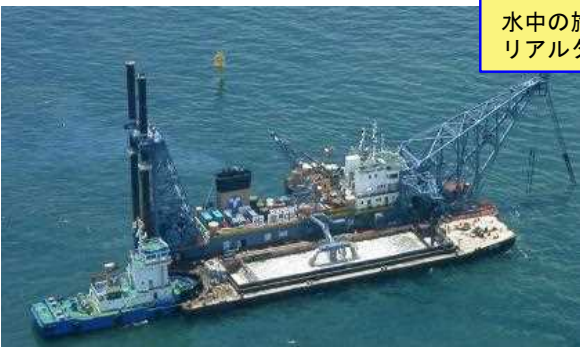
浚渫作業状況の可視化 (BIM/CIM)
