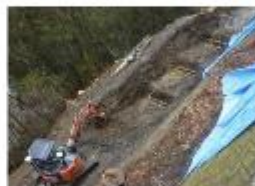
ICT建機による掘削作業
