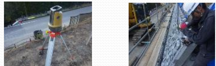
3次元施工データを構造物の据付に活用
