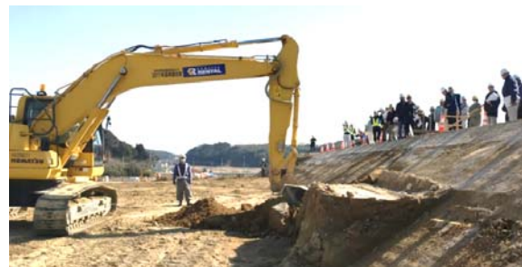
丁張り不要の圧倒的な 施工効率を体感
