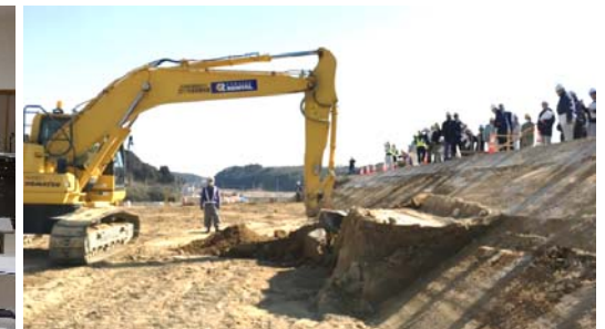
丁張り不要の圧倒的な施工効率を体感
