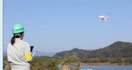
UAV 起工測量
