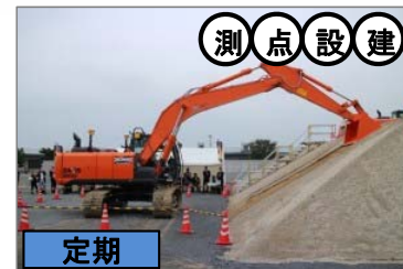
日立建機 ICTデモサイト
