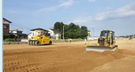
MCブルドーザ 路体盛土
