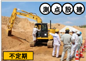
西尾レントオール テクノヤード
