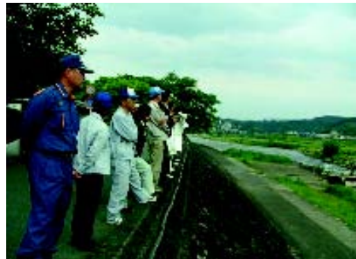
関係機関との合同での巡視
