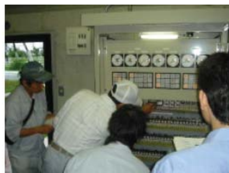
水門の開閉確認
