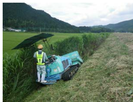
堤防の草刈り
