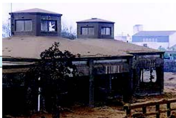
有珠山の噴火による泥流の被害
