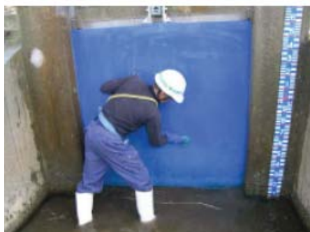
樋門ゲートの点検
