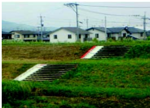
水位標の設置
