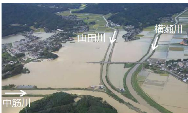
渡川水系中筋川・山田川・横瀬川 浸水状況（高知県宿毛市山奈付近）
