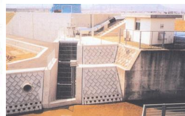
排水機場 写真：香川河川国道事務所資料より
