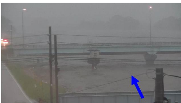
重信川の水位が出合橋の橋桁にせまる 出合基準地点の状況
