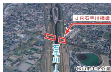
写真：松山河川国道事務所資料 より
