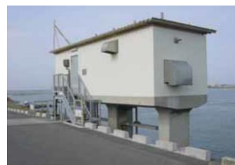
塩屋排水樋門
