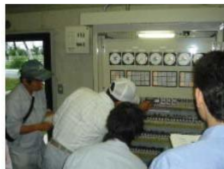
水門の開閉確認
