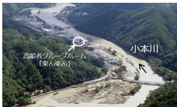
おもとがわ 小本川周辺の浸水状況
