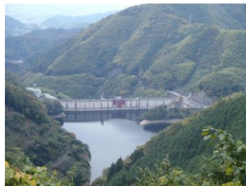
石手川ダム 写真：石手川ダム HP より
