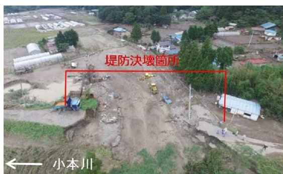
堤防決壊状況
