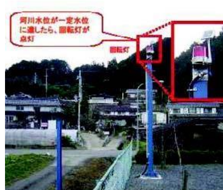
回転灯の設置
