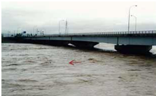
出合大橋下流の洪水流下の状況 （松前町西高柳地先： 重信川河口より3.3km付近 松前町側）
