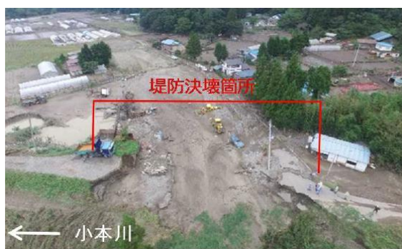
堤防決壊状況
