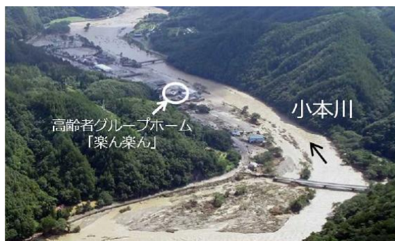
おもとがわ 小本川周辺の浸水状況
