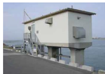
塩屋排水樋門
