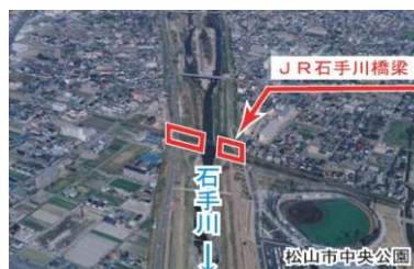
写真：松山河川国道事務所資料 より
