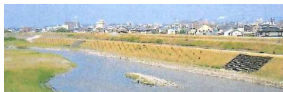
写真：松山河川国道事務所資料より
