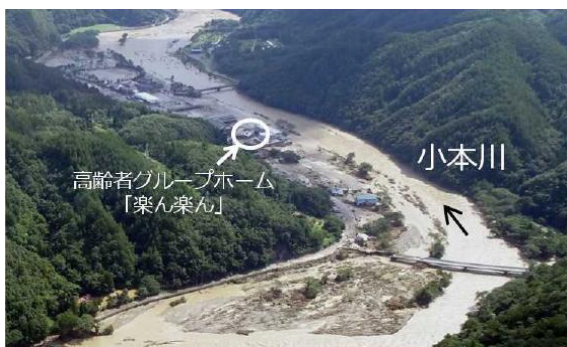
おもとがわ 小本川周辺の浸水状況
