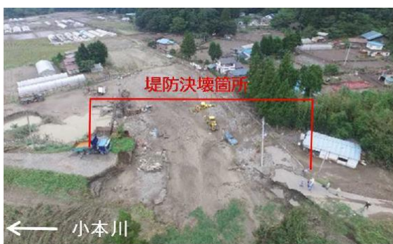
堤防決壊状況
