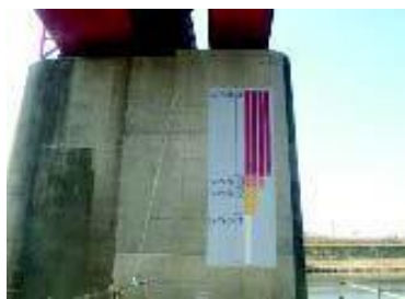
水位表示の例（橋げた）
