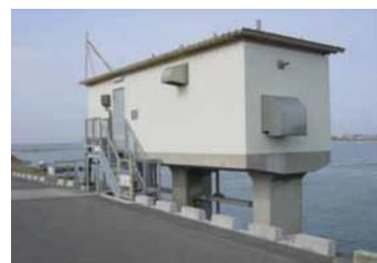
塩屋排水樋門
