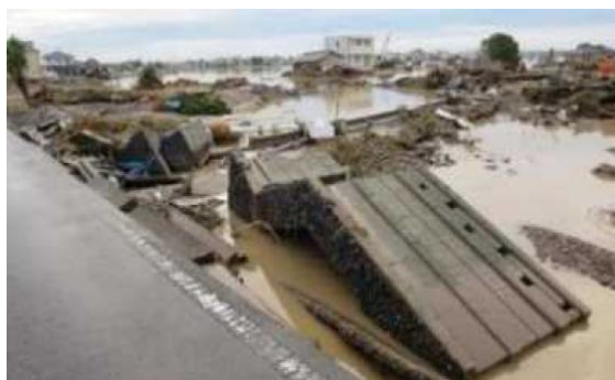
決壊箇所近傍家屋等の流出状況 (9月11日)
