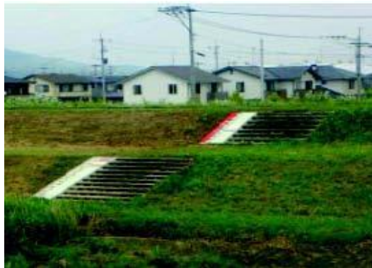
水位標の設置
