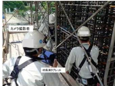
①臨場(受注者)の状況
