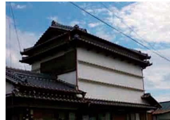
写真2.23 安芸市伝統的建造物群(高知県: K)
