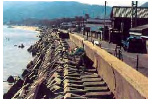
写真3.1 コンクリート護岸(香川県)
