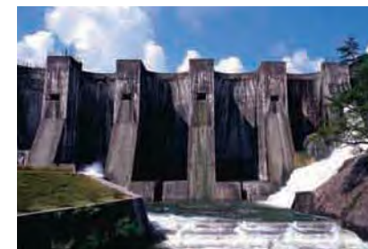
写真1.4 豊稔池石積式アーチダム(香川県)
