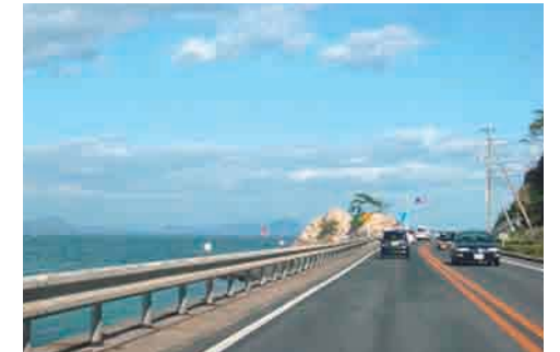
写真3.5 景観を阻害する防護柵(愛媛県)
