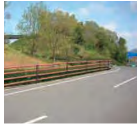
写真5.12 電線類の地中化事業 (徳島県・徳島市)
