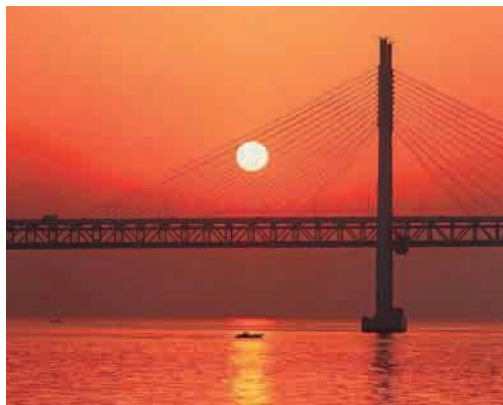
写真4.5 瀬戸大橋(香川県)
