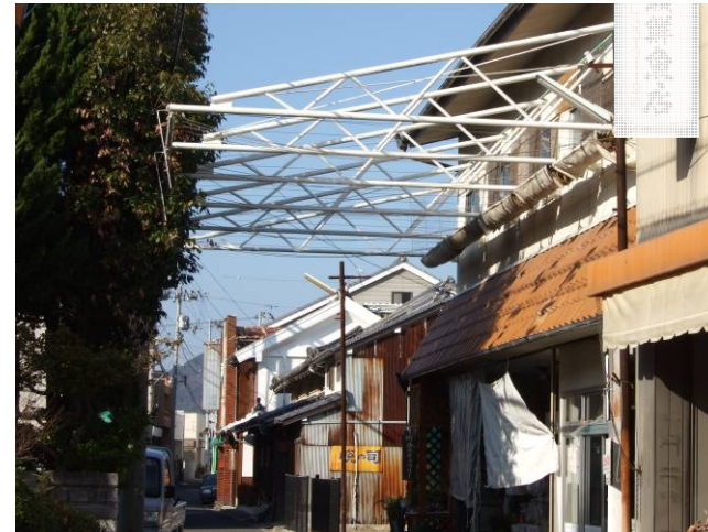
骨組みがむき出しのひさし
