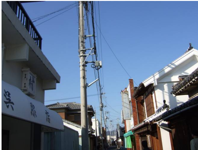
電柱・電線が目立つ
