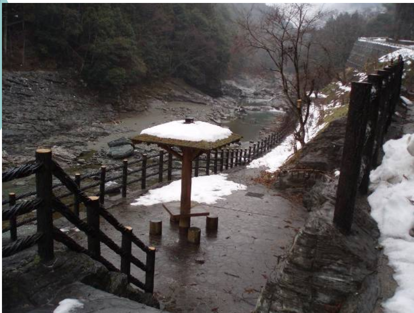
食堂・民家の移転により水際公園を整備（平成10年度）
