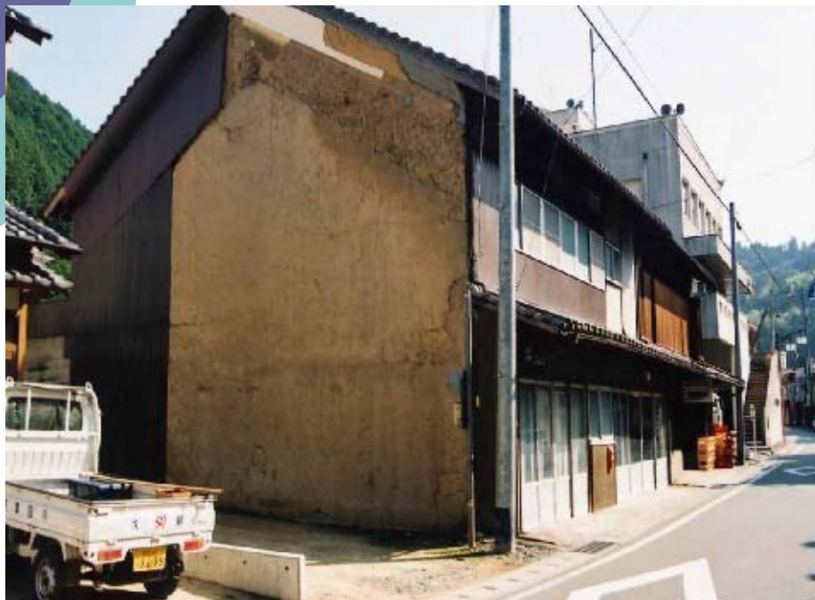
●住宅修景前(成留屋地区)
