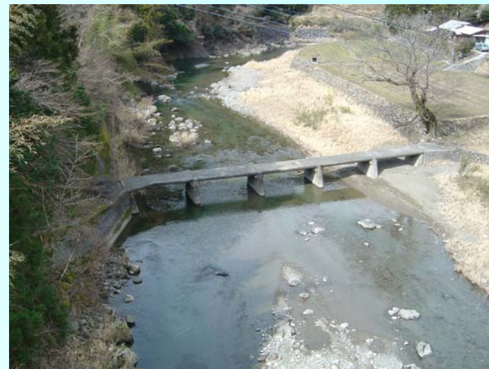
沈下橋と水田(梶原町)
