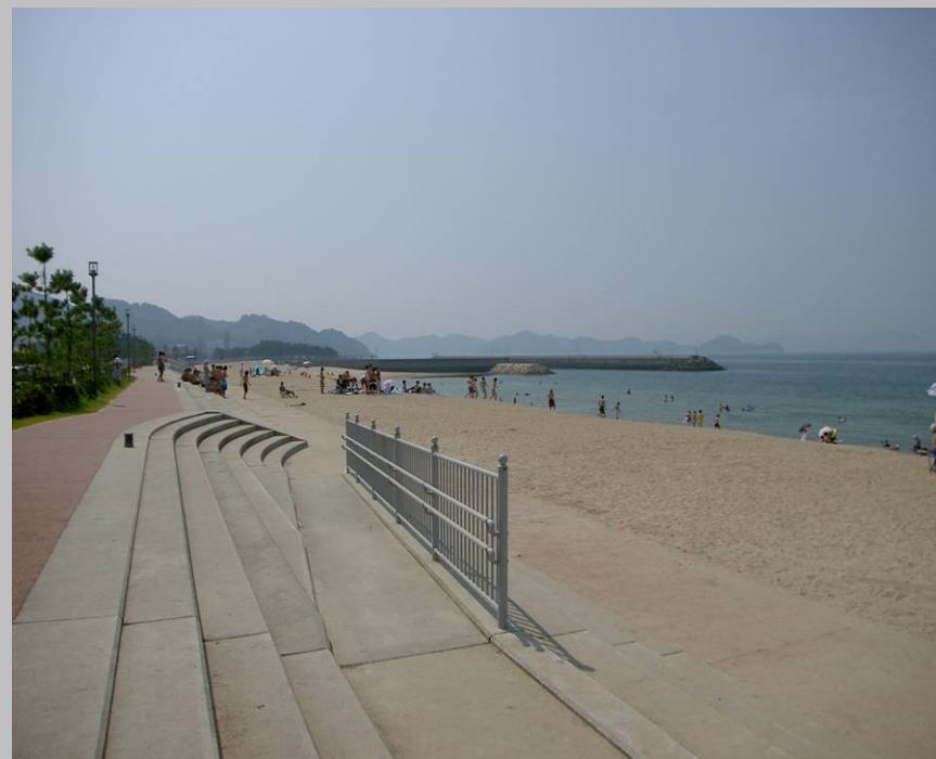
松山港海岸和気地区の堤防(愛媛県松山市) 13
