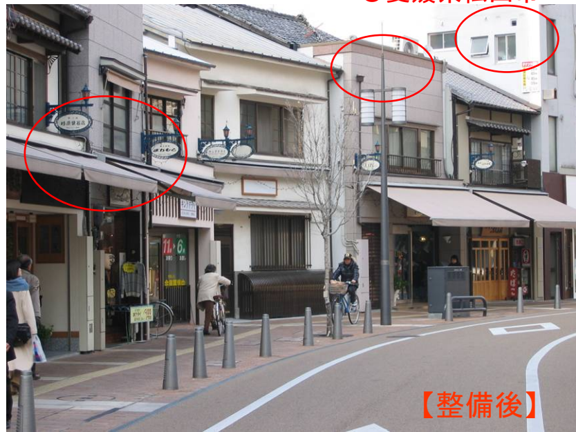
○アーケードの撤去と屋外広告物の統一
