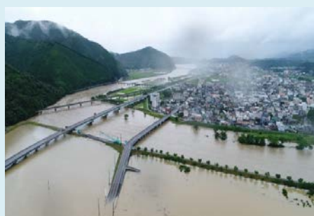
市内の冠水状況
