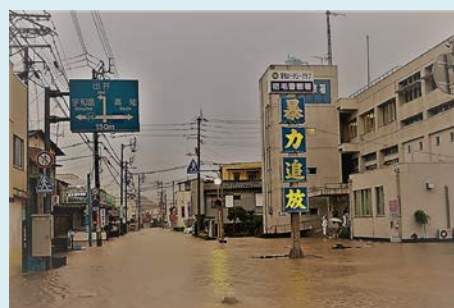
宿毛警察署付近冠水状況
