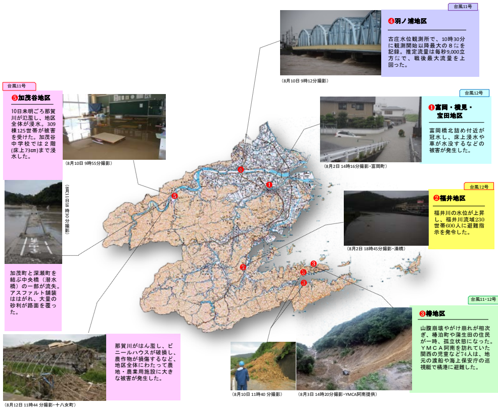
台風被害の概況（市提供資料（市の被害調査結果より））
