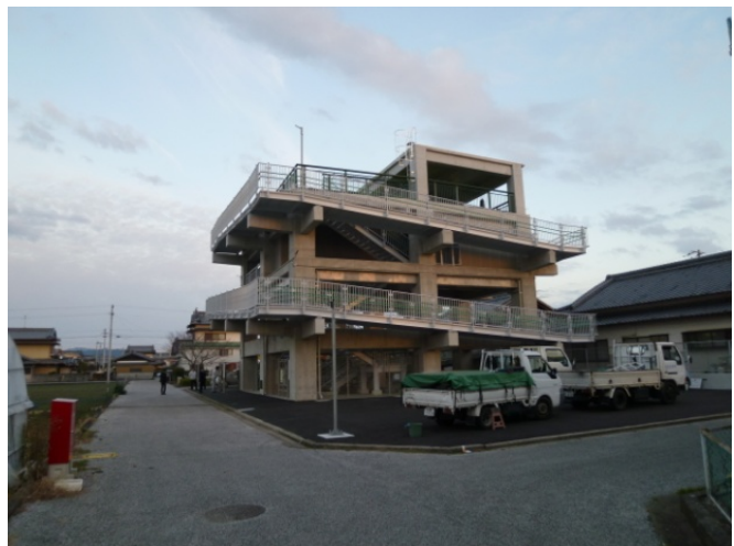
吉川町西南津波避難タワー
