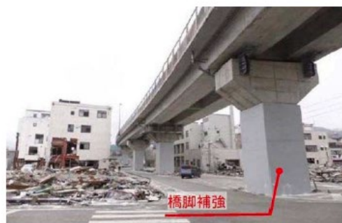
【耐震補強済み(鋼板巻立補強)】 地震動により損傷なし
