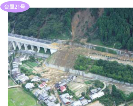
土砂崩壊[9月29日] (愛媛県新居浜市 大生院)
