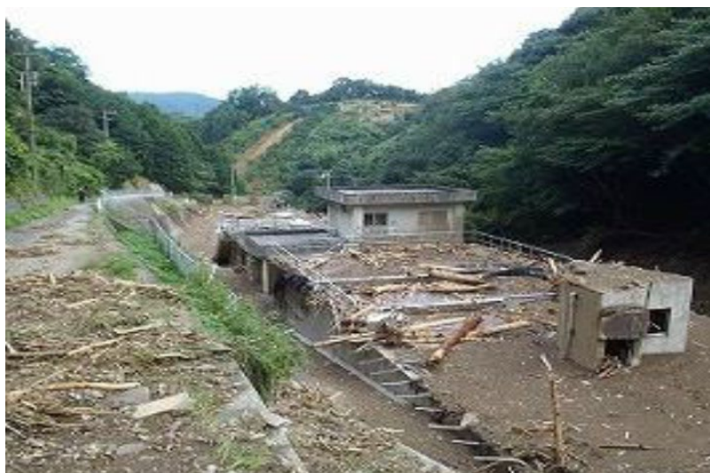
被災を受けた宇和島市吉田浄水場
