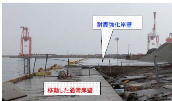
◇耐震強化岸壁(仙台塩釜港 仙台港区)
