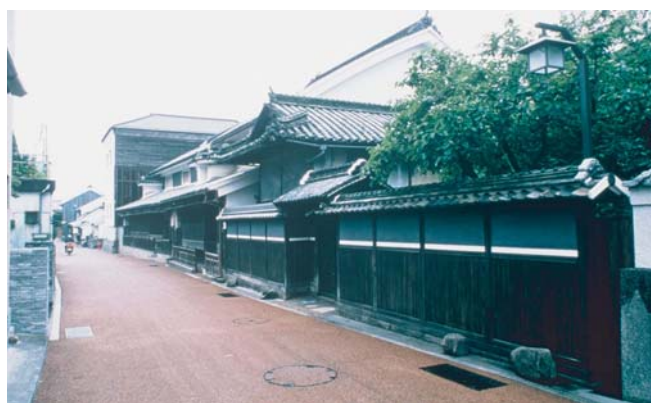
▲ うだつの町並み東端より西側を望む。正面建物は修理工事を終えている。
