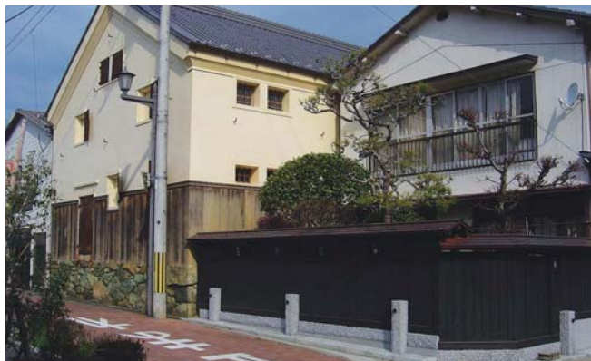
▲左の土蔵は、かつての木蠟倉庫を保全したものの、水害の歴史を物語る物件の一つで、商品を水害から守るために、石積みの上に土蔵が建築されている。右手の塀は、単なるブロック塀だったものを改修事業で改善したものの。
