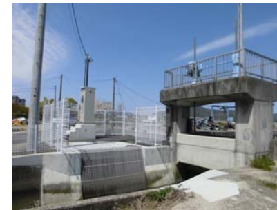
志度新町地区雨水・排水ポンプ場建設工事
