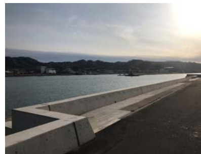
志度港塩屋地区津波対策工事
