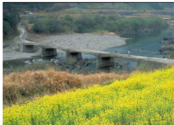
上岡沈下橋 (100k 付近)
