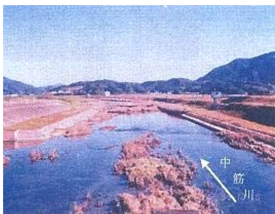
中筋川 5k 付近
