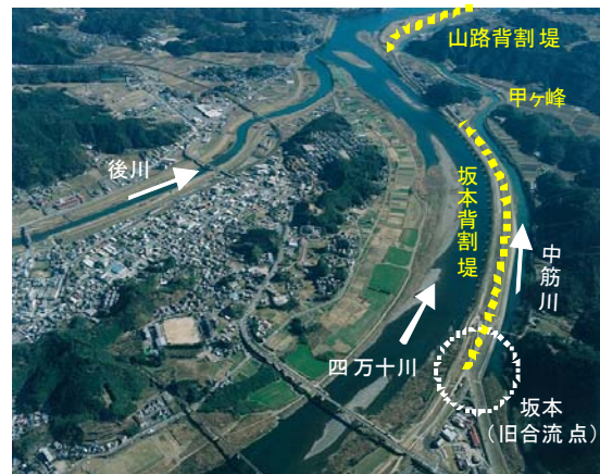
中筋川の改修
