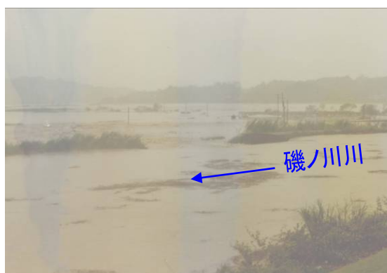
昭和 50 年 8 月洪水での磯ノ川（支川）決壊の状況
