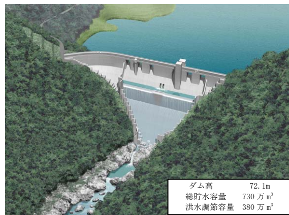
横瀬川ダム（建設中）
