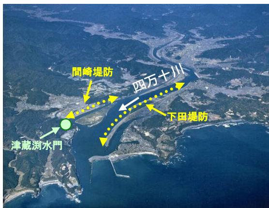
下田堤防・間崎堤防
