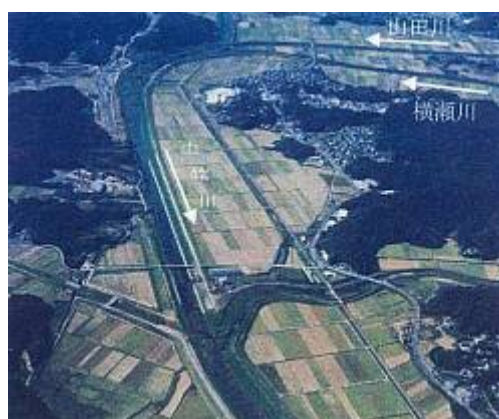
中筋川 15k 付近
