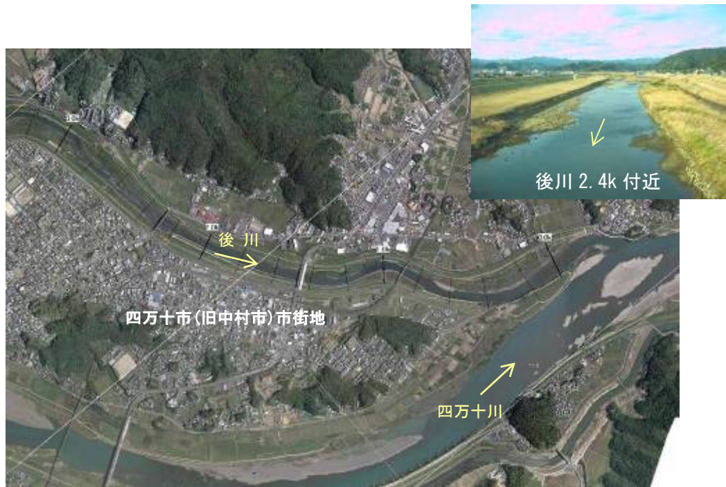
後川合流点付近
