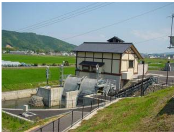
かわいすがわ 川家川排水機場
