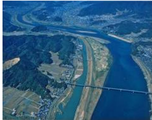
山路橋付近下流部(上流方向を望む)
