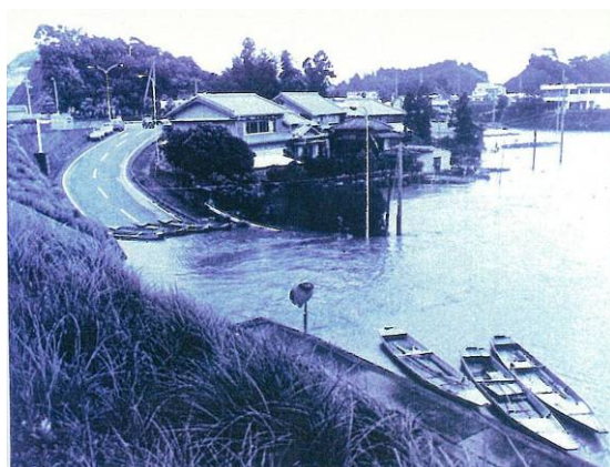
不破（無堤）地区付近の状況
