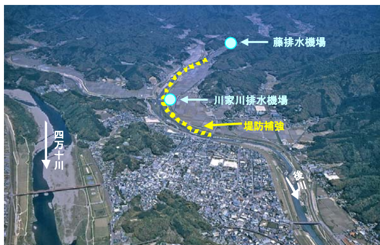
後川床上浸水対策特別緊急事業
