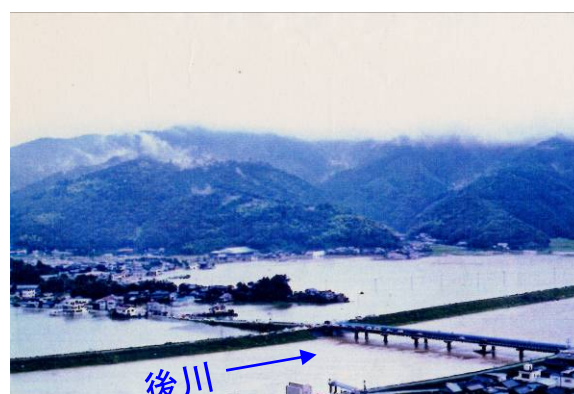
後川橋付近の状況
