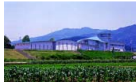
写真 9-4(1) 防災ステーション
