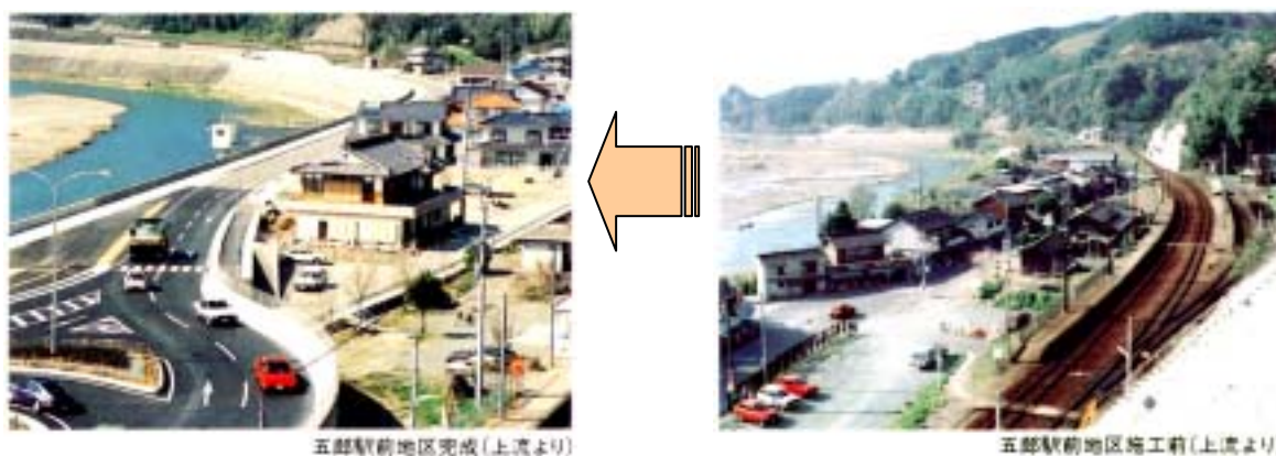
写真 4-2(2) 五郎駅前地区改修事業
