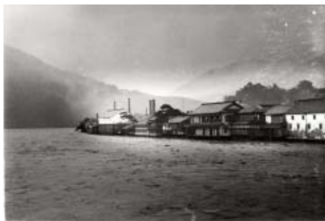
昭和 18 年 7 月洪水 肱川橋上流
