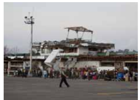
タクロバン空港ターミナル被災状況
