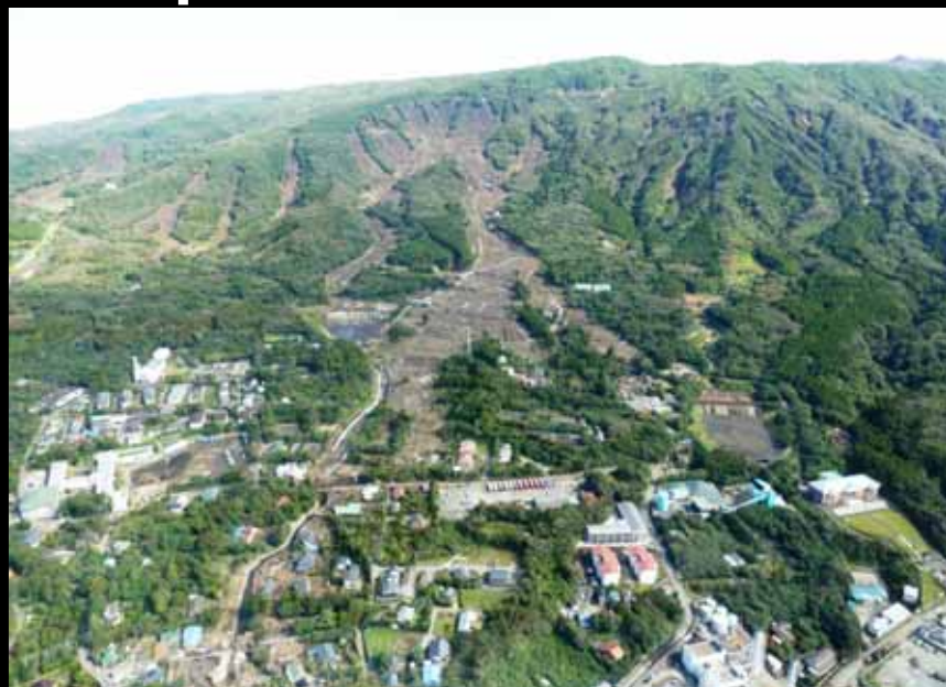
東京都大島町 台風26号による元町神達地区の被災状況
