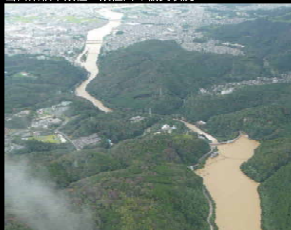
京都府 台風18号出水時の天ヶ瀬ダムと宇治市街
