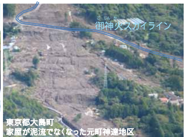
東京都大島町 元町神達地区の被災状況
