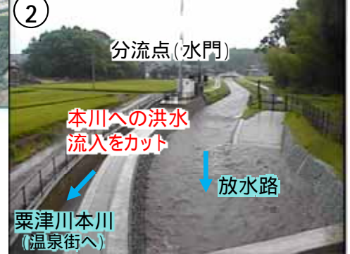
放水路分流点の状況
