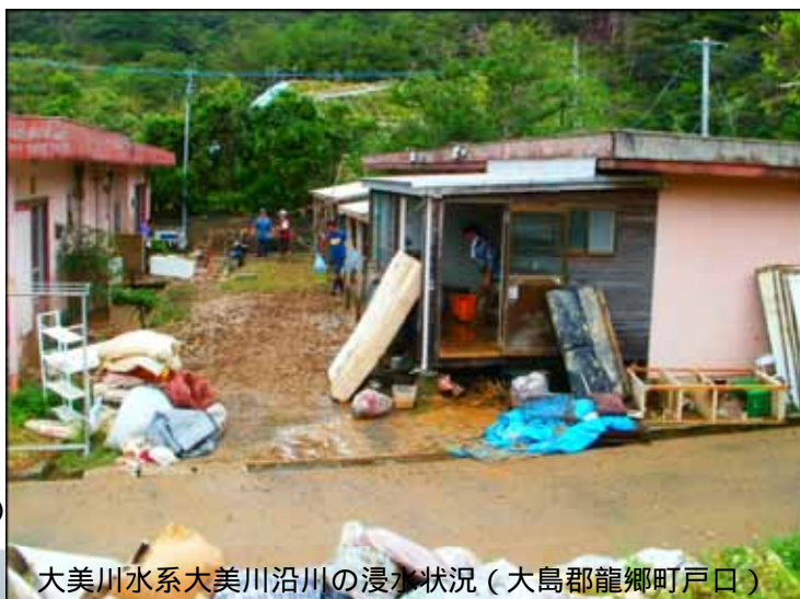
大美川水系大美川沿川の浸水状況（大島郡龍郷町戸口）
