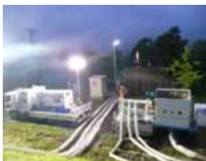
新潟県加茂市下条下興野排水状況
