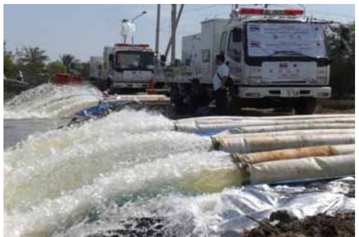
ポンプ排水の状況
