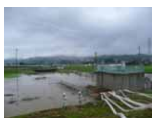
新潟県南魚沼市浦佐駅付近排水状況
