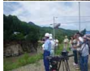
国道252号 二本木橋(福島県)被災状況調査
