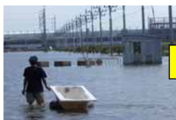
ロジャナ工業団地 排水前(11/23)
