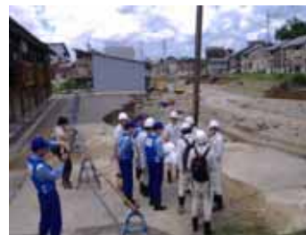
信濃川支川田川(新潟県)被災状況調査
