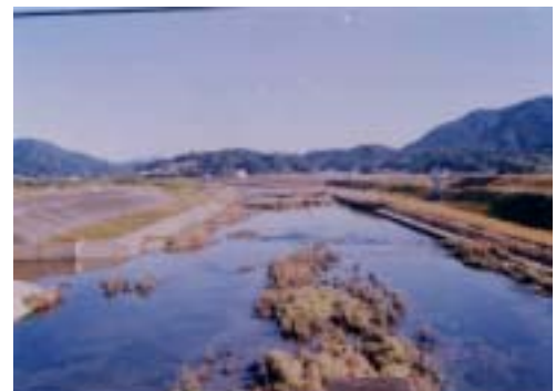
ヨシが繁茂した低水路（土居大橋下流）
