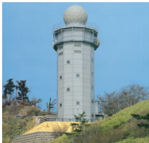
写真：レーダ雨量観測所
