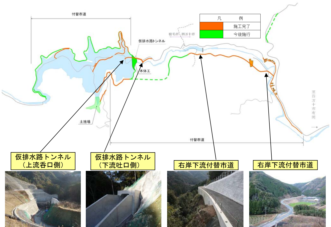
図 3-2-6 横瀬川ダム建設事業の進捗状況
