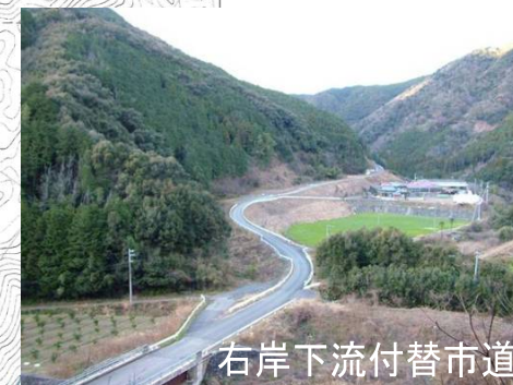
右岸下流付替市道
