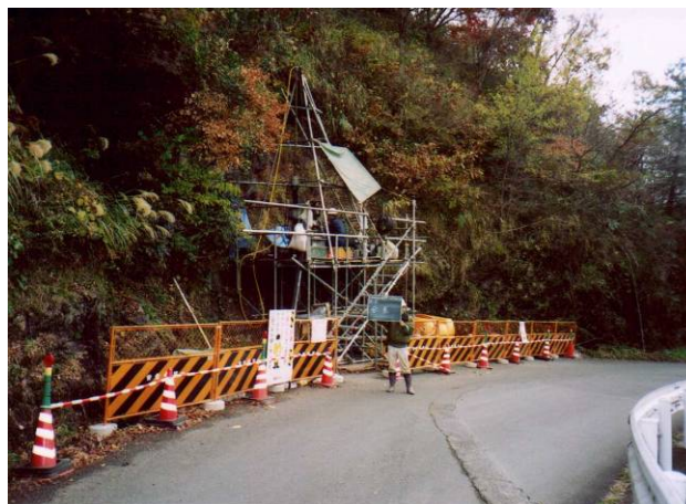
地質調査状況写真
