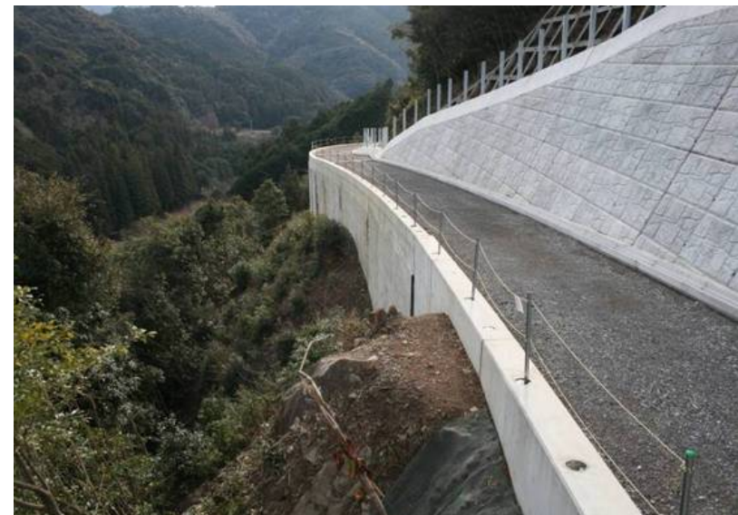
右岸下流付替市道
