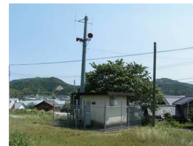
警報局(他ダム事例)
