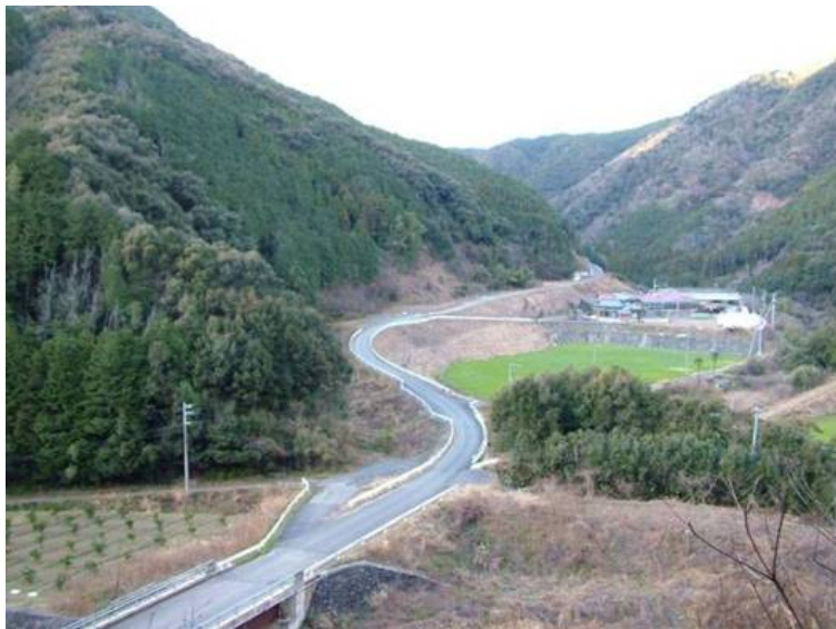
右岸下流付替市道
